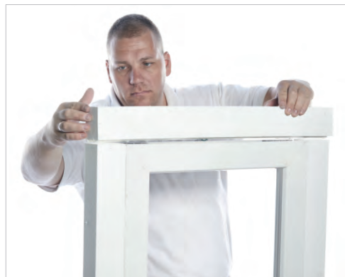
Raami eelkooste välmise paigaldamise puhul
